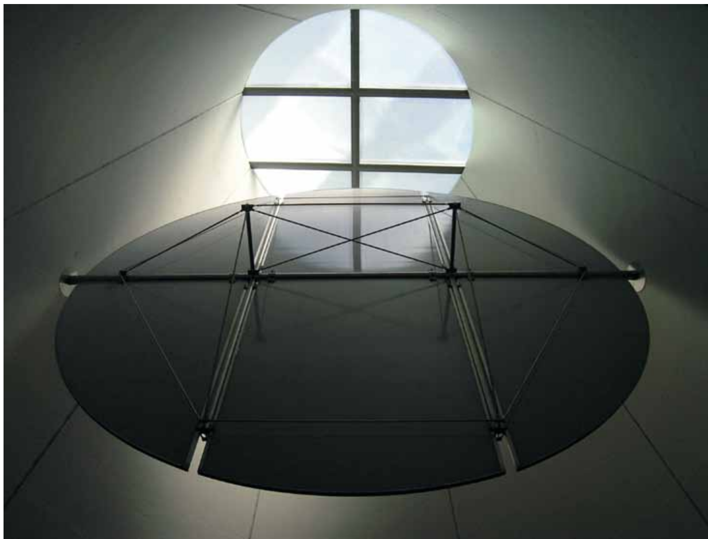
Obr. 20_Zatmívací světlíková klapka, nerezová ocel, polykarbonát, elektromotor, průměr 248 cm, Technická univerzita v Liberci, 2009, foto autor
