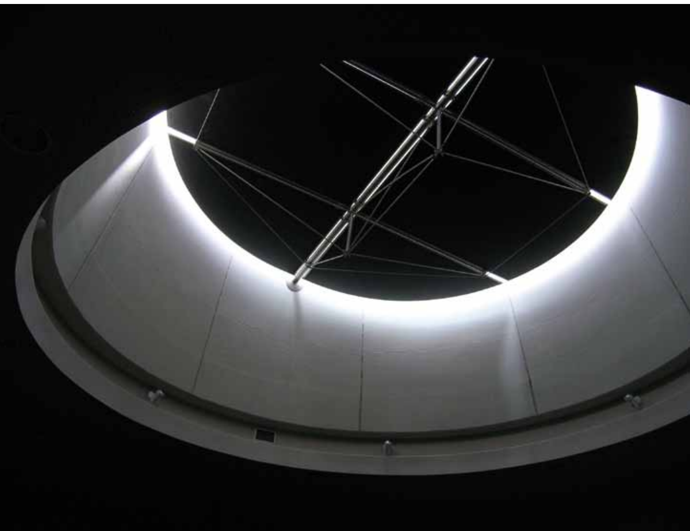
Obr. 19_Zatmívací světlíková klapka, nerezová ocel, polykarbonát, elektromotor, průměr 248 cm, Technická univerzita v Liberci, 2009, foto autor
