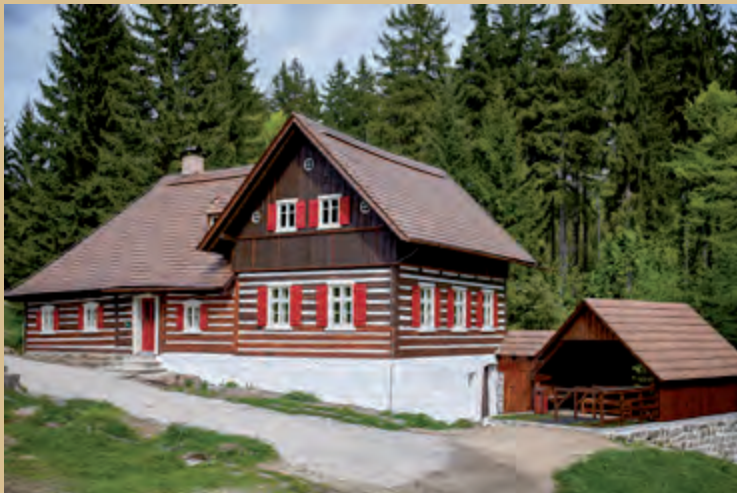
Fuchshaus nach der Rekonstruktion / Fox House after the reconstruction, Foto / photo Martin Koubek, 2017, MSB
