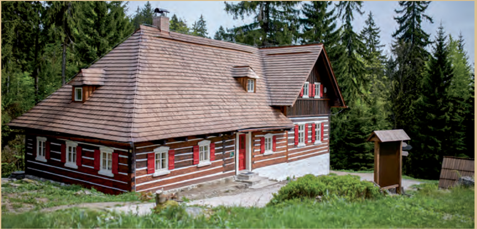
Fuchshaus nach der Rekonstruktion / Fox House after the reconstruction, Foto / photo Martin Koubek, 2017, MSB
