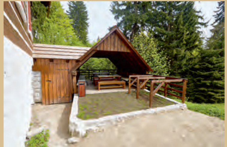
Fuchshaus nach der Rekonstruktion / Fox House after the reconstruction, Foto / photo Martin Koubek, 2017, MSB
