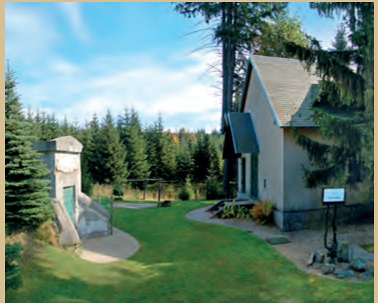
Wasserwerk / Waterworks, Foto / photo Roman Karpaš, 2007, AA
