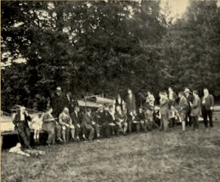
Das letzte Bautreffen vor der Feier / The last construction meeting before the celebration, Foto / foto Heinrich Walter, JDGV (1926)
